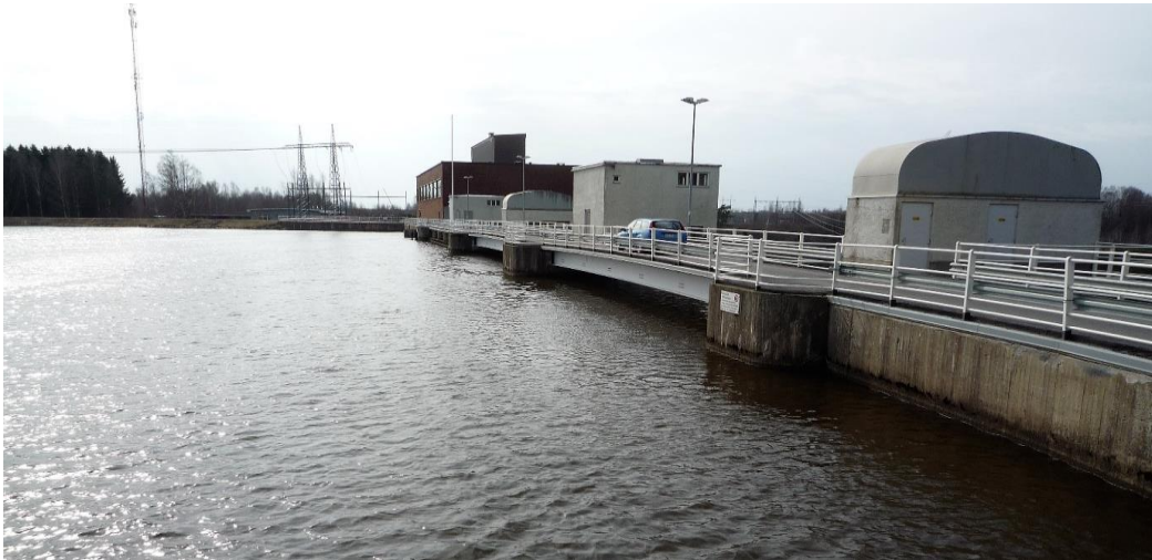
Kuva 23. Joen ylittävä betoninen pato-osuus on noin 240 metriä pitkä. Sen jatkeena on 400 m pitkä maapato. Betoninen pato lepää Kokemäenjokilaakson "peruskallion", hiekkakivipatjan päällä. Padon kansi toimii henkilöliikenteen siltana. Valokuva: Lasse Lovén.
